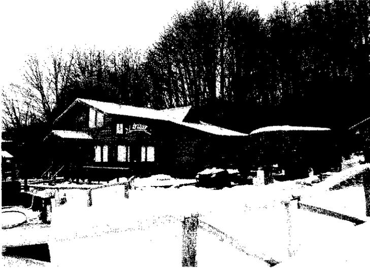
Vivienda de dos plantas enfrentada al salón comedor sobre la margen izquierda del mismo la que consta de construcción de madera en planta baja y alta, semicubierto en el acceso, recubrimiento exterior de tingladillo de madera en su totalidad el techo es de chapa de zinc, al costado de la misma se observa un galpón de estado muy precario como leñero y deposito.
